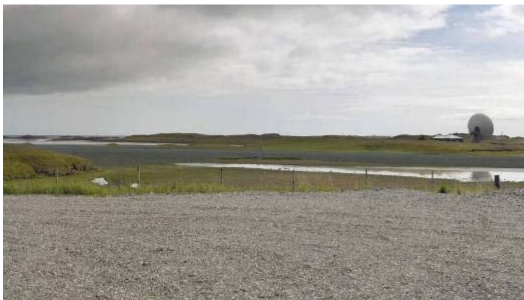
Mynd 6.29. Horft frá Hafnarnesi til suðausturs yfir leið 3. Búið er að skeyta tölvuteiknaðri framkvæmd inn á ljósmyndina.
